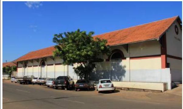
Prédios de apoio, ao lado da estação.
